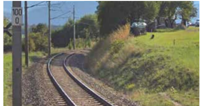
Eingleisige Pyhrnbahn mit typischem Bogenradius in Ardning; Quelle: Google Maps (Okt. 2020)
