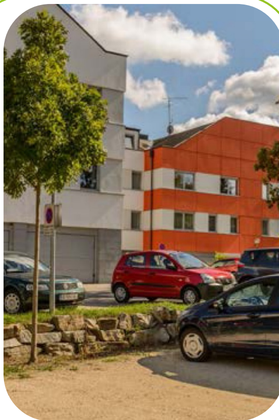
Fotografie Nestmelený povrch na parkovišti, s. 2
