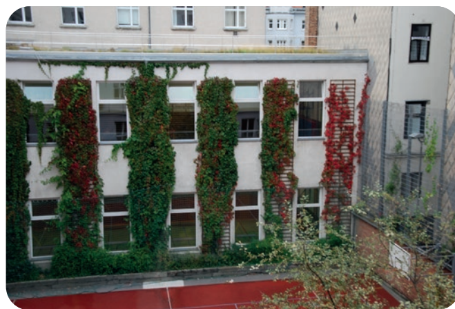
Obr. 9: Ozelenění fasády školy, Kandlgasse Wien, zdroj: © GRÜNSTATTTGRAU
