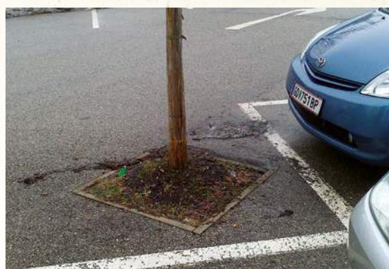
Ein eingeschränkter Wurzelraum ist eines der Hauptprobleme, mit denen Bäume im Siedlungsbereich konfrontiert werden.
