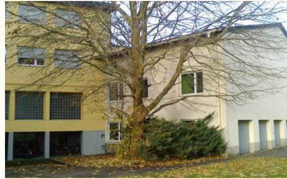
Viel zu großer, noch junger Baum (Platane) zwischen Gebäuden
