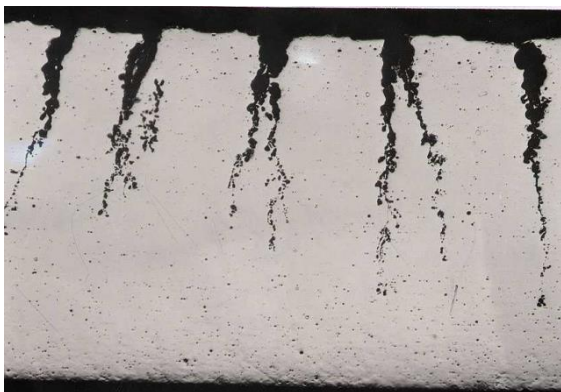
Obr. 7.4 Mikrofotografie korozních trhlin
