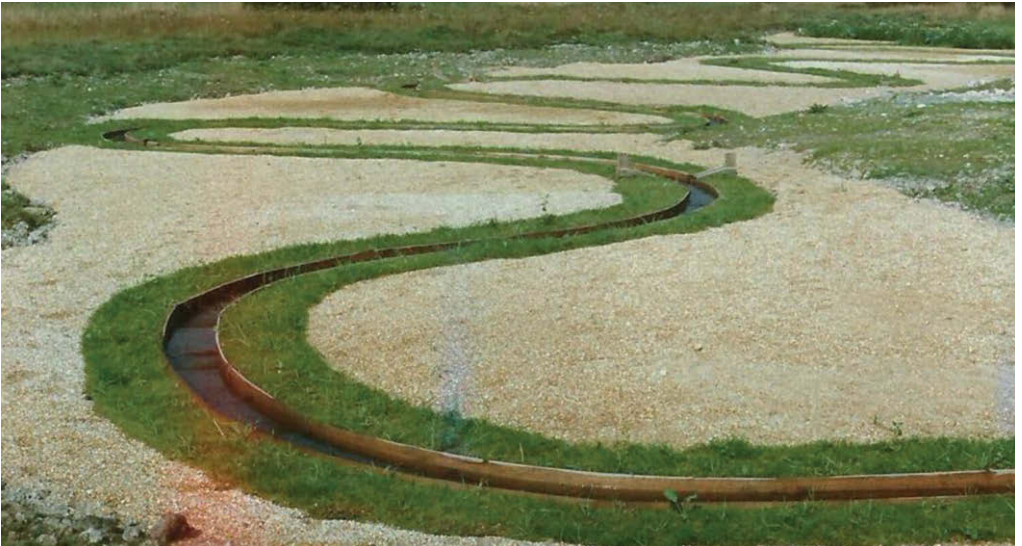
Umělý odchovný prvek pro odchov perlorodek říčních dle Hrušky během výstavby. (Foto: O. Spisar) Muschelgraben nach Hřuska während der Errichtung. (Fotoquelle: O. Spisar)
