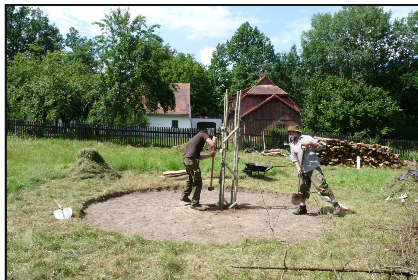
Prvotní fáze výstavby milíře. Příprava plochy a stavba „krále“.
