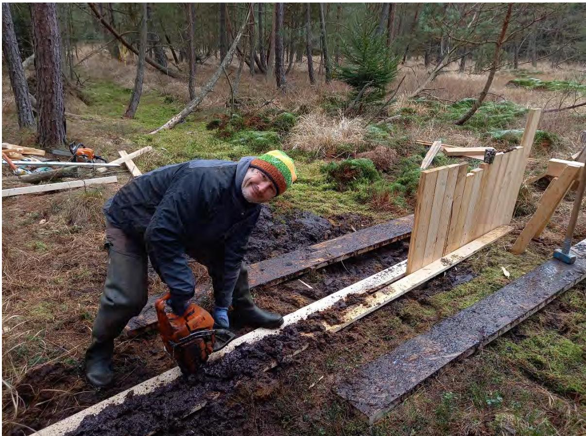
*Abbildung 46 Einbau von Holzsperrn zur hydrologischen Sanierung des Bummermoos. Winter 2020.
