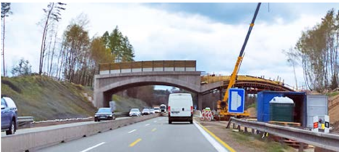
Abbildung 16: Eine Grünbrücke, die auf der Autobahn D1 für den Wildtierkorridor im Abschnitt zwischen Jihlava und Měříň gebaut wurde. Die Autobahn D1 ist im Raum der Böhmischo-Mährischen Höhe für Großsäuger völlig unpassierbar. Vier neue Grünbrücken sollen diese Situation deutlich verbessern. . © V. Hlaváč
